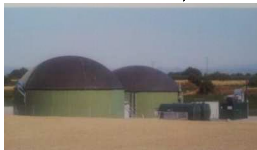
Planta de Biogàs
